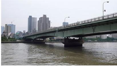
に架けられた橋であり、上流に平行している永代橋、下流の勝鬨橋の交通量の増加、および東京オリンピック開催に備えた関連道路の一部として、戦後初めて隅田川に架橋された橋である。右岸側では隅田川の手前100mほどの位置から高架が始まり、左岸では月島全幅にわたって高架のまま、朝潮運河に架かる朝潮大橋へと繋がっている。これは桁の下面から水面までの距離を勝鬨橋と合わせたためである。また他の隅田川にかかる橋は川に対してほぼ直角に交わっているが、佃大橋は中心線が岸に対して60度ほど斜めになっている。本橋は個性的なデザインの多い隅田川橋梁群の中で、一見無個性で無粋な橋といわれがちであるが、大ブロック工法など、当時の技術の粋を凝らし、オリンピックに間に合わせるために急ピッチで架橋され、むしろ戦後に急速な復興を遂げた高度成長期の日本を象徴した橋といえる。その構造形式は主桁 3径間連続鋼床鉄箱桁橋で、長さ40m、重量150トンに及ぶブロック別に当時日本最大の海上クレーン船にて一括で組み上げるという、大ブロック工法の先駆けともなる画期的な橋でもあった。橋長 476.3m。
